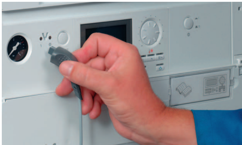
Dobrze konserwowana instalacja grzewcza zapewnia niezawodne ciepło w domu
